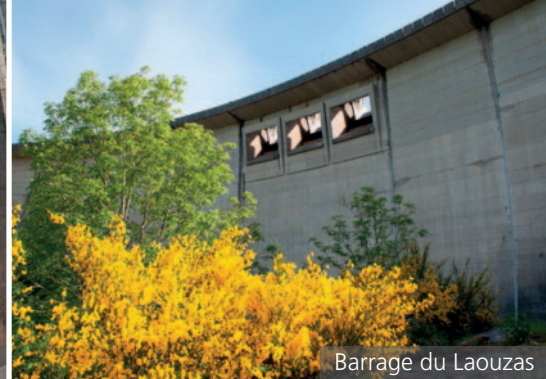
Barrage du Lauzas
